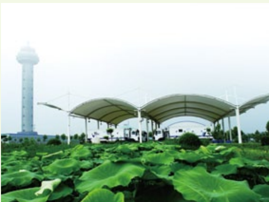
厂区水循环项目
